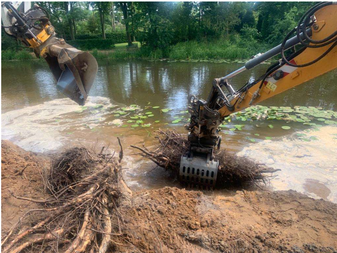
Figuur 3.4: Voorbeeld van de aanleg van houtpakketten in de Graafsche Raam
