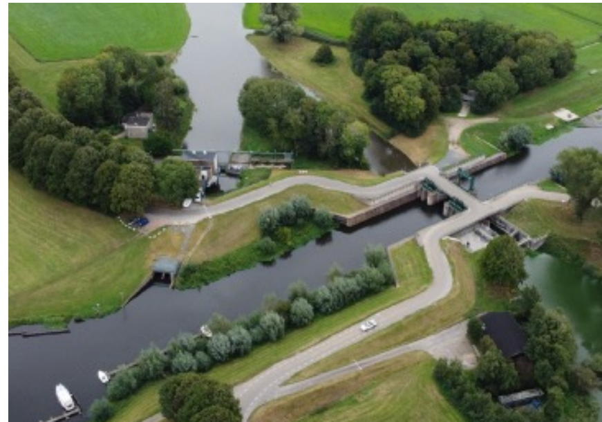
De Bovenlandse Sluis, het Oude Maasje en gemaal Gansoijen
