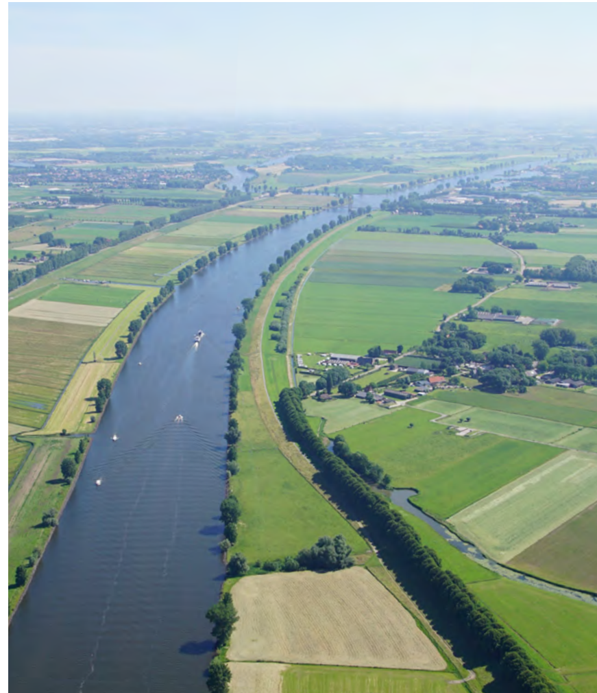
Dijk en het Oude Maasje ter hoogte van de Heusdenseweg
