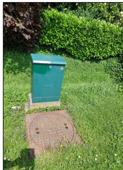
Afbeelding 13: Drukriool put (aansluiting op persriool)
