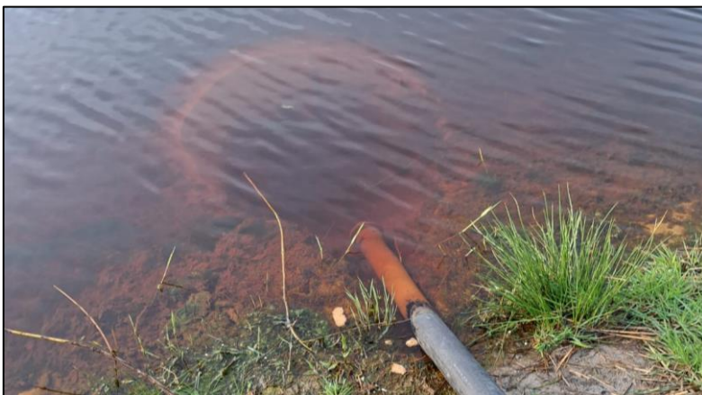
Afbeelding 7: Lozing ijzerrijk water vanuit een bronnering
