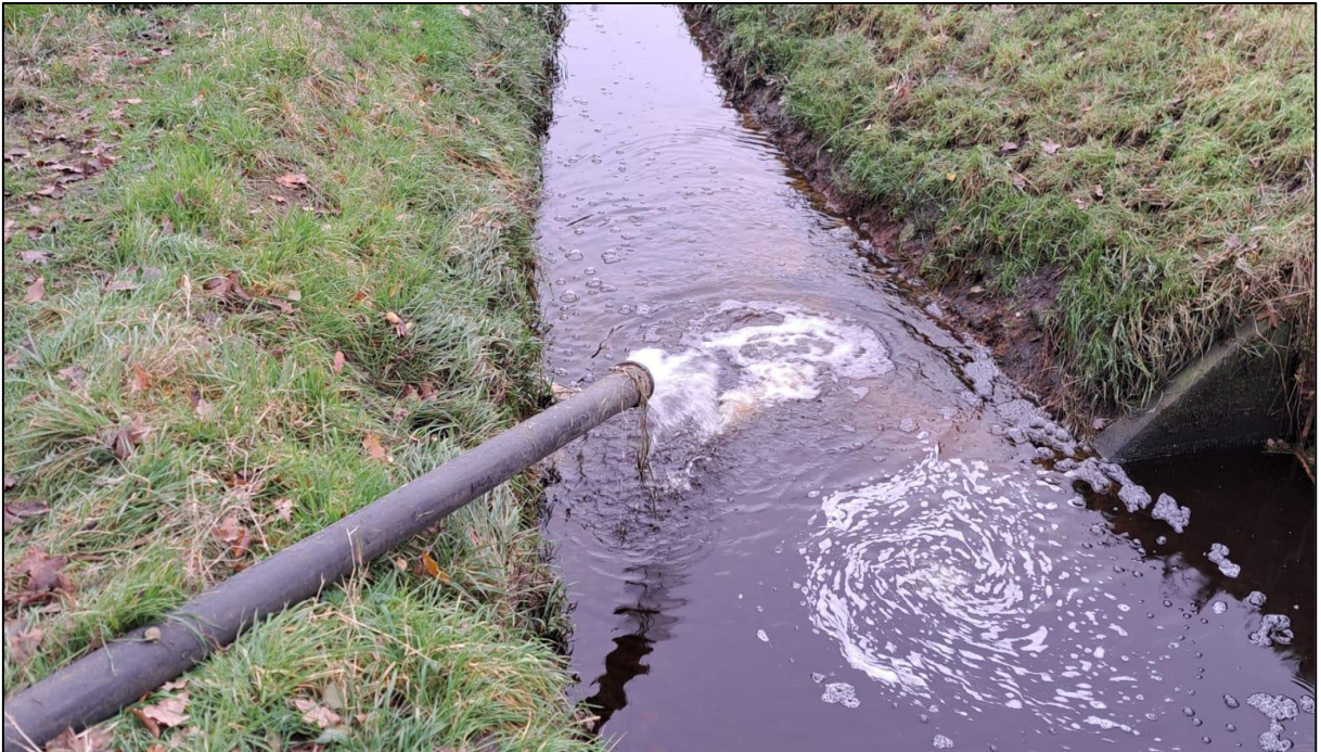
Afbeelding 17: Lozing vanuit een bronnering
